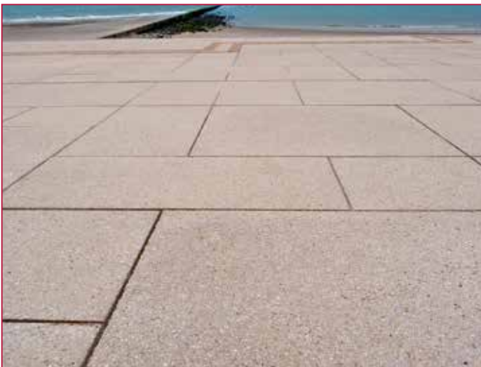
Betonsteinplatten im Großformat 120 x 120 cm, 60 x 60 cm und 120 x 60 cm
