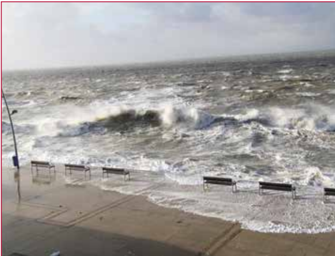
Der Fugenmörtel hält Orkan „Christian“ mühelos Stand
