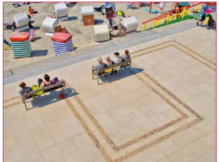
Die Verlegung der Platten war ein Kraftakt, ein Großformat wiegt bis zu 536 kg
