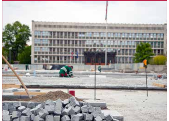
Verlegung des Kleinsteinpflasters | Laying of the small paving stones Polaganje malih kamnitih tlakovcev
