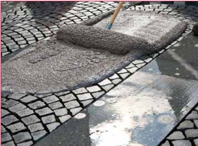
Verarbeitung des ROMEX® Pflasterfugenmörtels | Application of ROMEX® pavement fixing mortar | Priprava malte za tlakovanje ROMEX®
