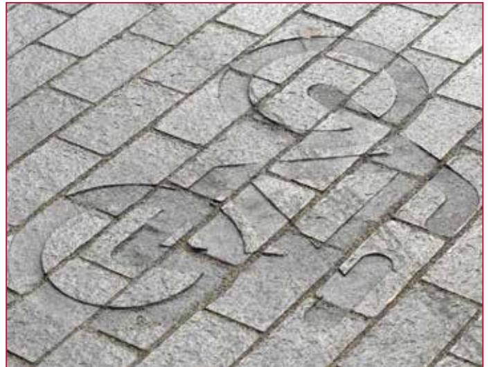
Detailaufnahme der geprägten Steine | Detailed photo of embossed stones | Útjelzés
