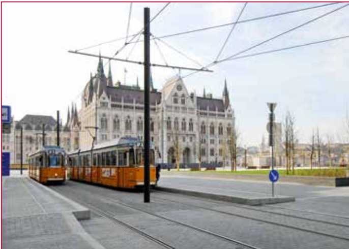
Auch rund um die Gleise der Metro Station wurde verfugt Jointing was carried out all around the platforms at the Metro station A villamos megállók burkolata megegyezik a tér általános burkolatával
